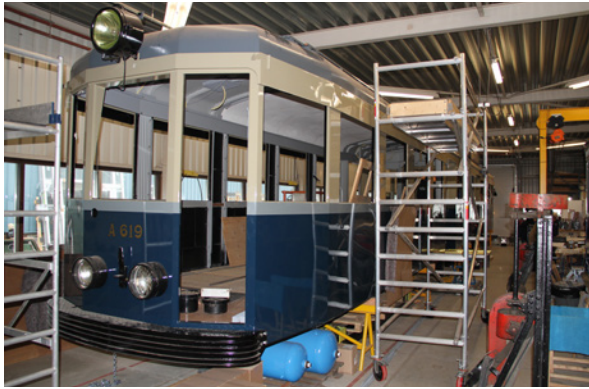
A 619 gedeelte, is begonnen aan de afwerking van het plafond.
