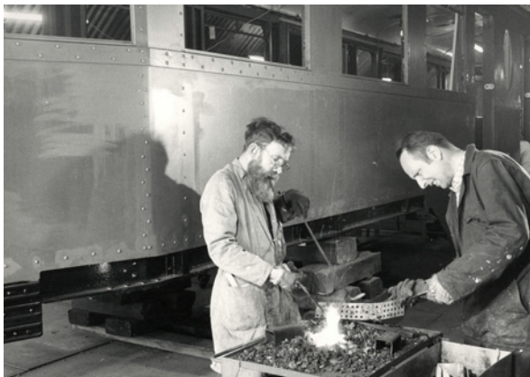
Peter Nieuwenhuis en Frits van Dam stoken de klinknagels roodgloeiend. Nieuwe beplating wordt pneumatisch vastgeklonken.
