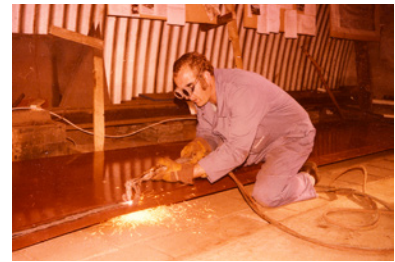
Jaap de Wit, huisvlijt aan koersborden, etc. Lex van Niekerk, klinknagels verwijderen. Ton Boon maakt de beplating op maat.
