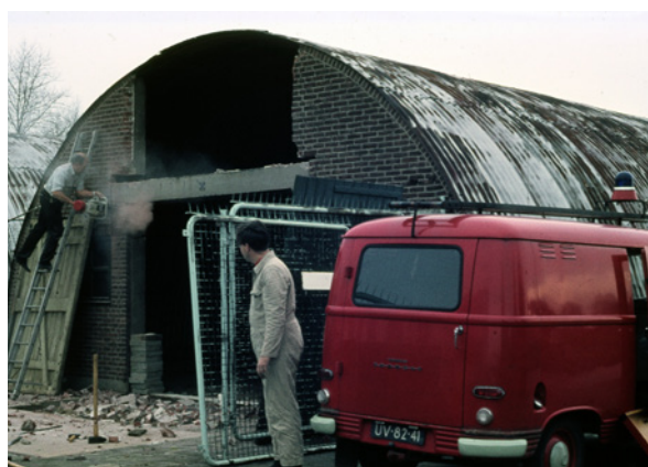
Links brandweerman Henk Vis met het verwijderen van een betonnen latei werd de toegang voor de B 412 vrijgemaakt. Rechts Karel Hoorn, die medewerking verleende.
