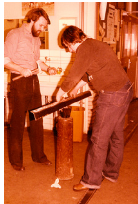
De stroomkabel, 220 Volt. Binnen in de hoek kwam de stroom binnen. Klinken en lassen van de klinknagels in de dakgoot.
