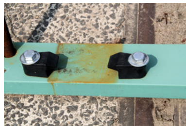
Positioneren tramrails, gevat in trillingvrije kunststof profiel Polycorp.
