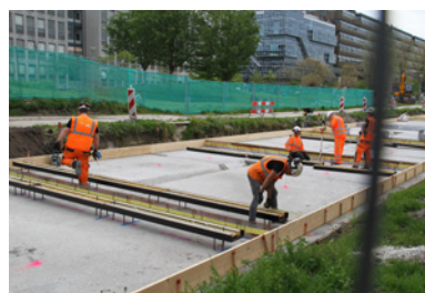
De volgende laag is vezel-versterkt beton.
