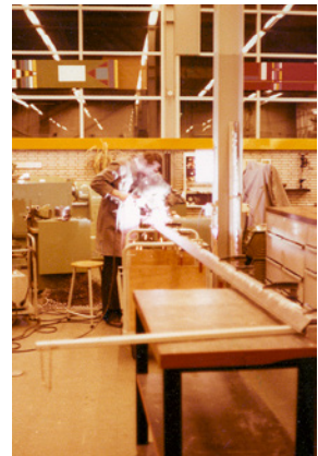
De stroomkabel, 220 Volt. Binnen in de hoek kwam de stroom binnen. Klinken en lassen van de klinknagels in de dakgoot.
