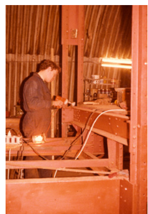
Verwijderen van de beplating. Oude nummering werd zichtbaar. Nieuwe profielen aanbrengen. Frank Haalmeijer, ontroesten!
