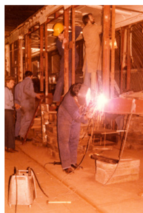
Verwijderen van de beplating. Oude nummering werd zichtbaar. Nieuwe profielen aanbrengen. Frank Haalmeijer, ontroesten!
