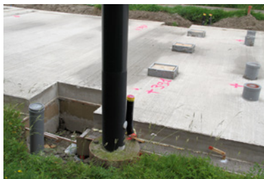
Basislaag klaar voor het opstellen van de rails.
