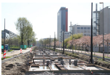
In afwachting voor de tweede betonlaag.
