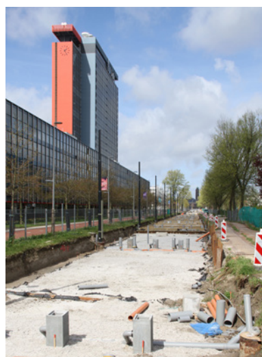
Basislaag en schuimbeton plus bewapening.
