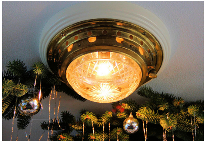
NZH plafonnière op zolder.
