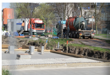
Schuimbeton wordt gestort.
