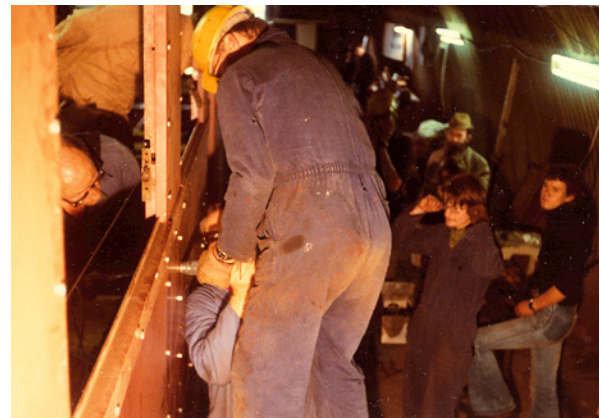
Peter Nieuwenhuis en Frits van Dam stoken de klinknagels roodgloeiend. Nieuwe beplating wordt pneumatisch vastgeklonken.
