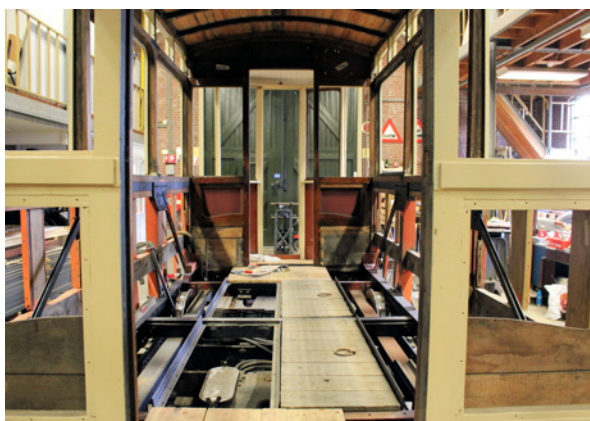
Interieur zonder plafondlatten en vloer, 26-9-2024.
