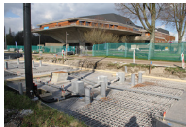
Basislaag en schuimbeton plus bewapening.
