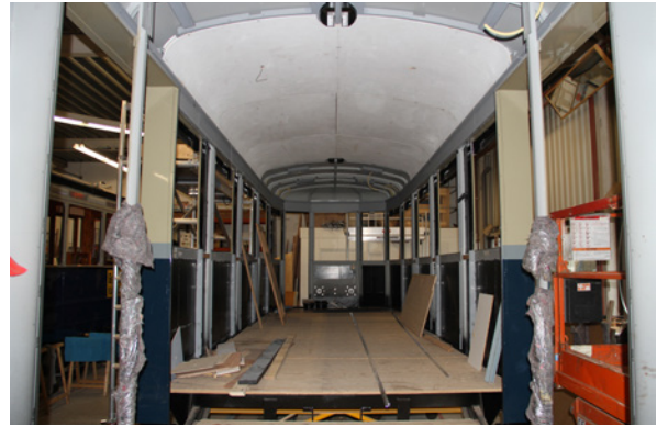
Plafond nog zonder verlichting.
