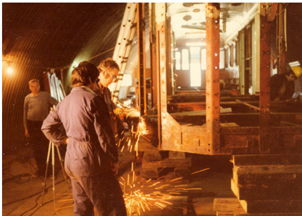
Slijpwerk, om nieuwe profielen te kunnen aanbrengen.
